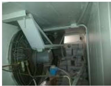
Foto.3 Compresor Copeland de 5HP.
